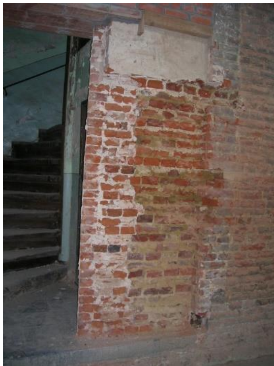
Afbeelding 81 (linksonder): gedecapeerde gevel met sporen van de weggebroken steunberen en dicht gemetste deur naar preekstoel
