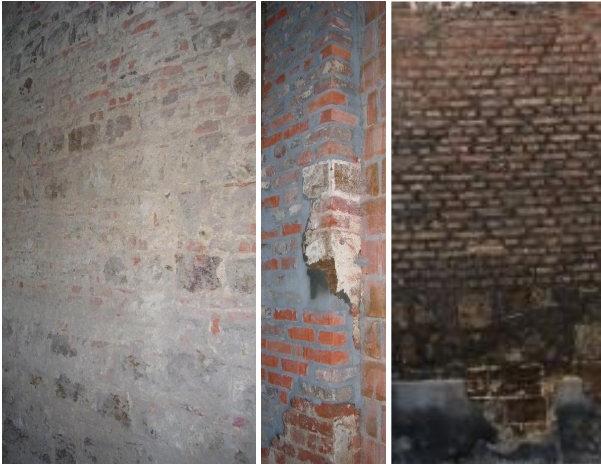
Afbeelding 31 (links): achtergevel: muur in metselwerk met speklagen en een ijzerzandstenen plint
