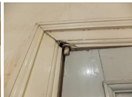
Afbeelding 84: detail beslag deur opkamer
