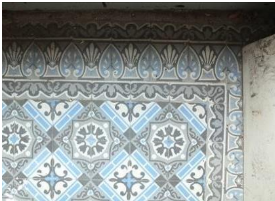
Afbeelding 79: cementtegels en fries
