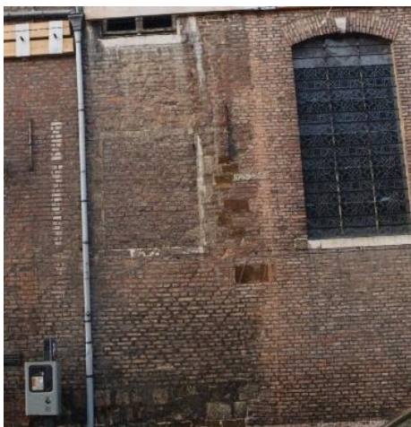
Afbeelding 7: overgangsnad in de voorgevel, sporen van de hoekstenen in ijzersteen
