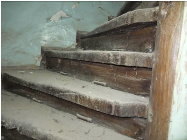
Afbeelding 94: uitslijting looplijn
