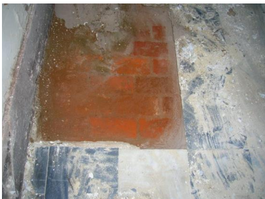
Afbeelding 53: ondervloer kapel in baksteen
