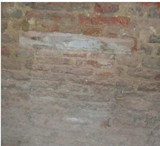
Afbeelding 51: dicht gemetst kelderraam apotheek (zijde gang)
