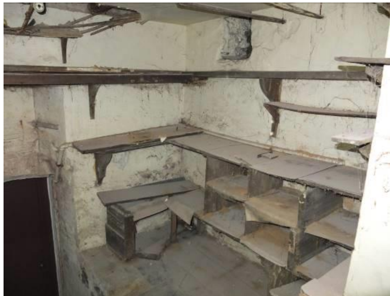
Afbeelding 98: wandmeubilering in de eerste kelder
