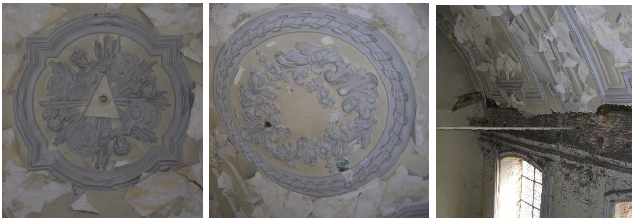
Afbeelding 14-16: Stucwerk van het tongewelf
