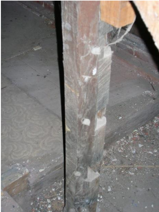
Afbeelding 28: as van de vroegere spiltrap
