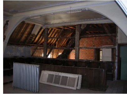
Afbeelding 46: detail hand gesmede spijkers Afbeelding 47: vakwerkwand oksaal
