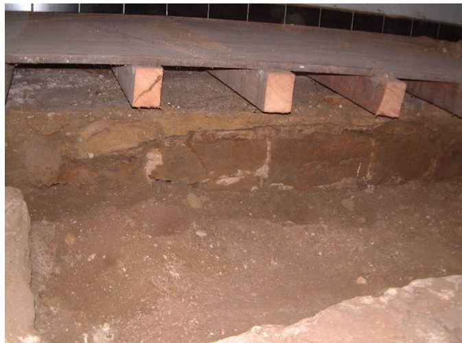
Afbeelding 14 en 15 (links): vijftiende-eeuwse vloerrestanten Afbeelding 16 (rechts): oude funderingsmuur in ijzerzandsteen
