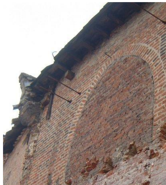
Afbeelding 6: dicht gemetst raam achtergevel kapel
