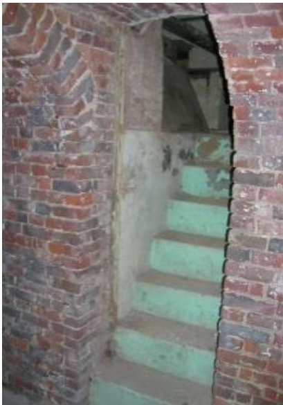
Afbeelding 97: trap tussen kelders
