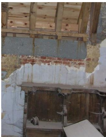
Afbeelding 45: sporen van een dakkapel in het oksaal
