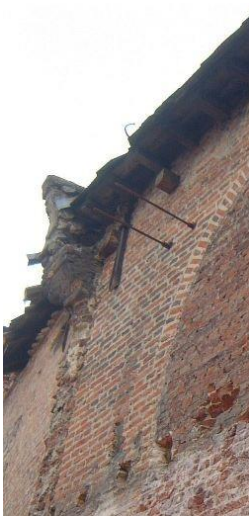
Afbeelding 10: sporen van de steunberen die in 1910 werden afgekapt
