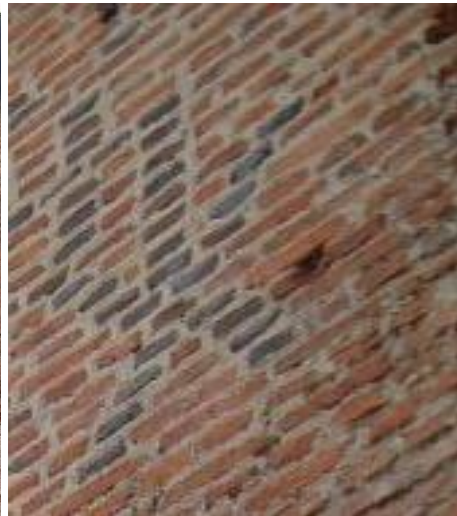
Afbeelding 10: sporen van de steunberen die in 1910 werden afgekapt
