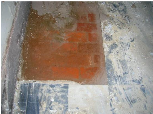
Afbeelding 39: ondervloer kapel in baksteen
