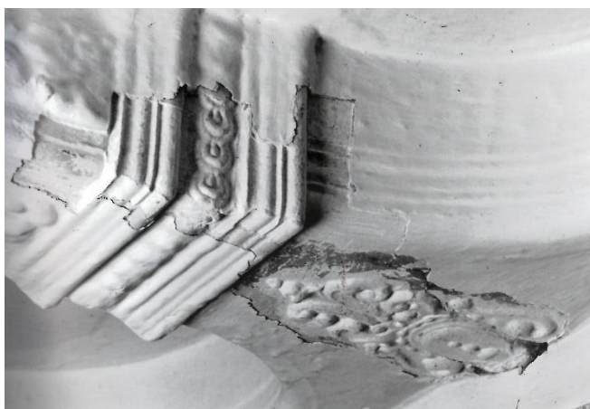
Afbeelding 1 (links): vrijleggen van details na verwijderen verflagen
