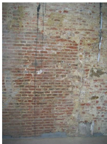
Afbeelding 7: overgangsnad in de voorgevel, sporen van de hoekstenen in ijzersteen
