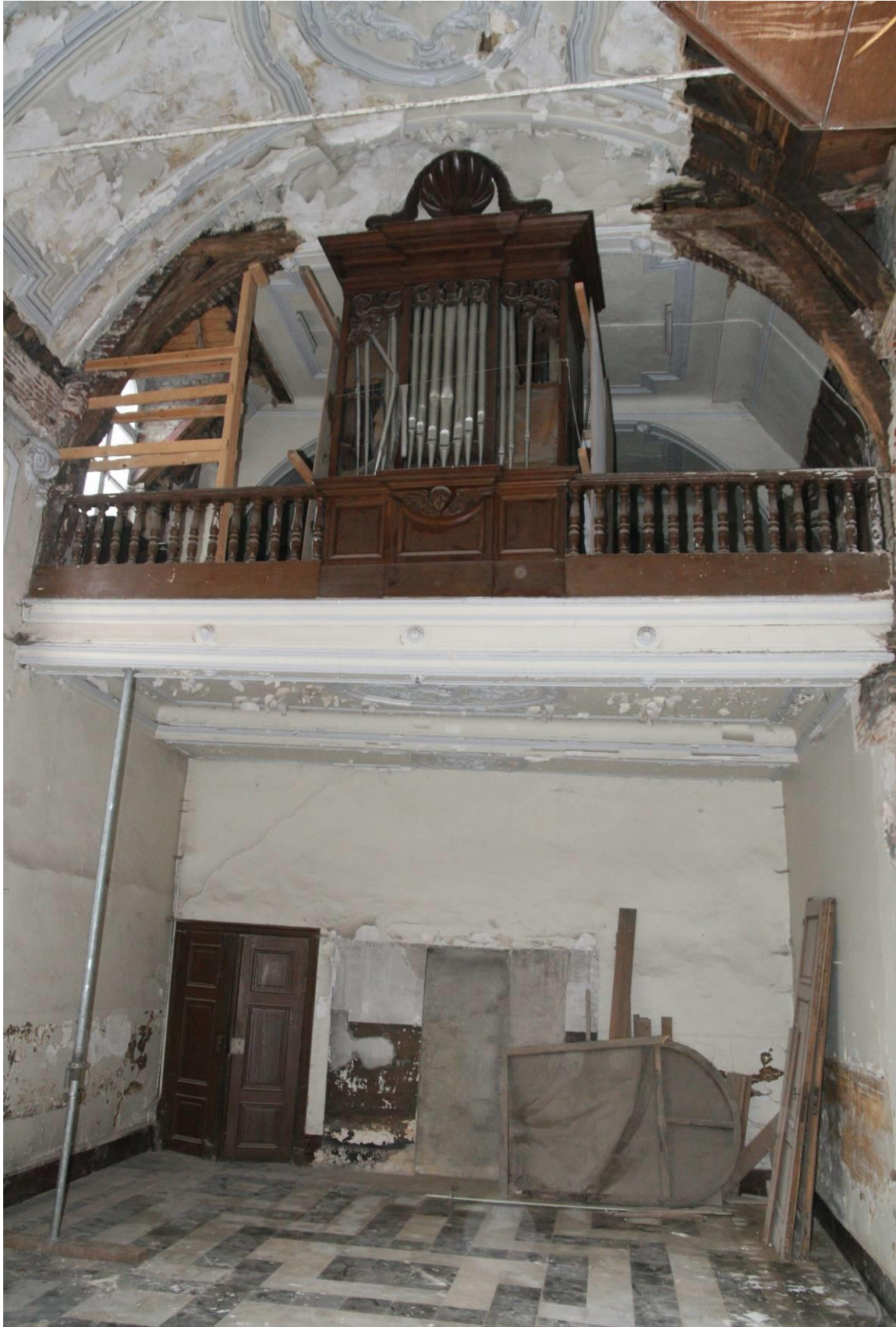
Afbeelding 13: Zicht richting het oksaal met orgel, centraal onderaan stond vroeger de biechtstoel. Rechts bovenaan: schade door aantasting huiszwam
