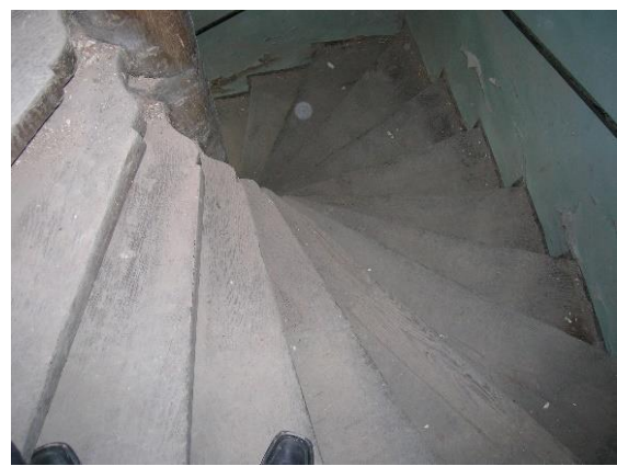
Afbeelding 93: bovenaanzicht trap, profileringen in trede
