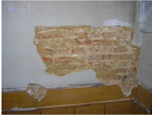
Afbeelding 48: Metselwerk tussen apotheek en zijkamer
