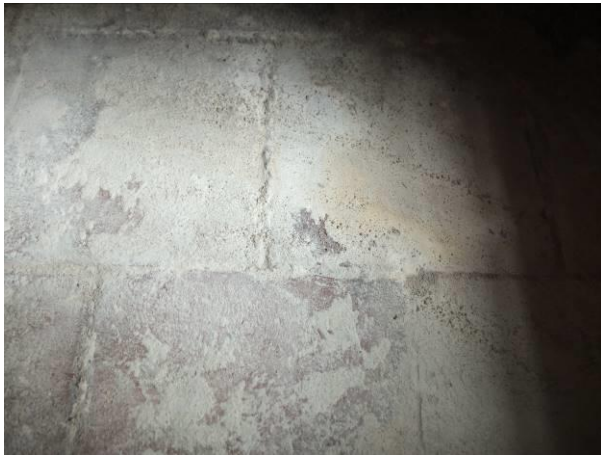
Afbeelding 72: Plavuizen onder het podium
