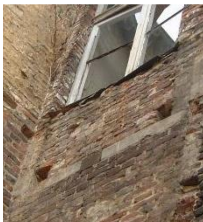
Afbeelding 46: sporen van een dakkapel in de achtergevel
