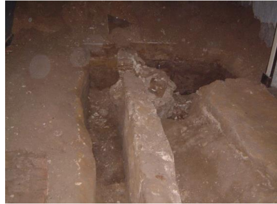
Afbeelding 17: funderingsmuurtje in gerecupereerde ijzersteen
