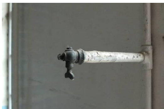
Afbeelding 76: relict gasverlichting
