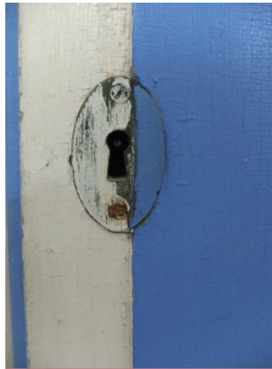
Afbeelding 63: oorspronkelijk sleutelplaatje
