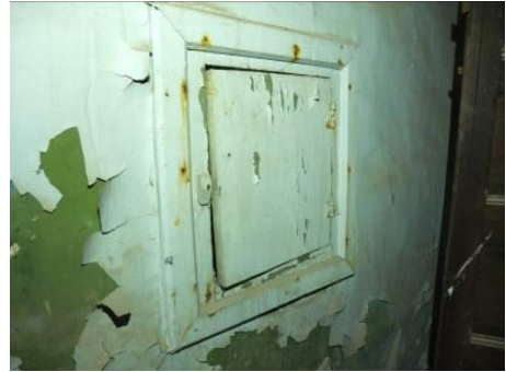
Afbeelding 96: doorgeefluikje naar kelder, oorspronkelijke mosgroene verflaag
