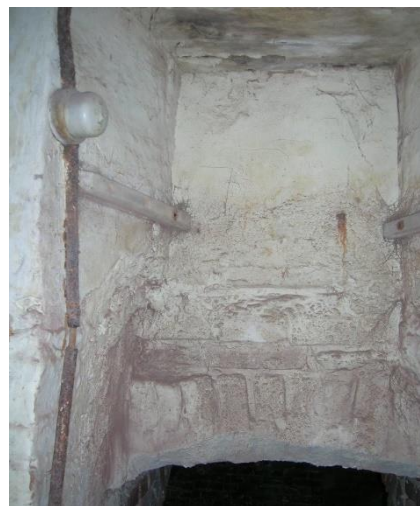
Afbeelding 52: dicht gemetst kelderraam apotheek (zijde kelder)
